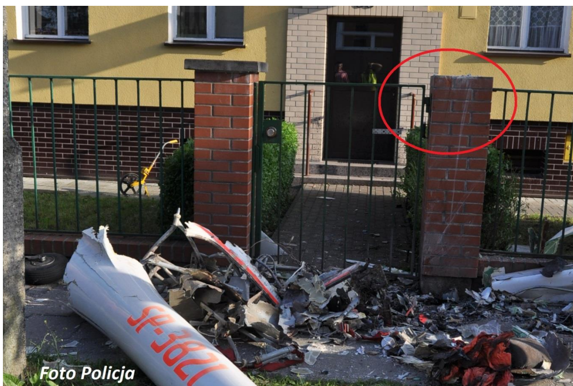
Rys.5 Uszkodzone ogrodzenie budynku mieszkalnego.
