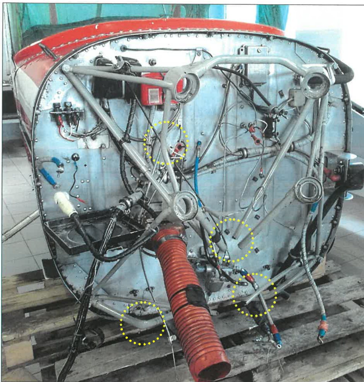
20 – Widok na przegrodę ogniową po demontażu silnika. Dobrze widoczne uszkodzenia i lokalne zniszczenia łoża silnika (rozerwania, zgięcia).
