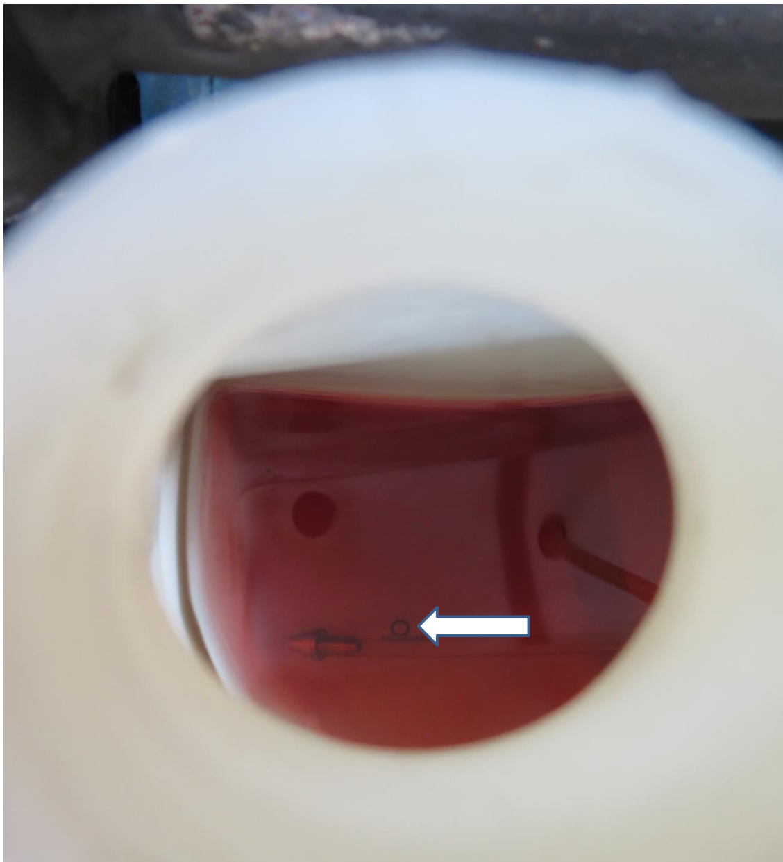
Rys.11 Widok podkładki leżącej na dnie zbiornika
