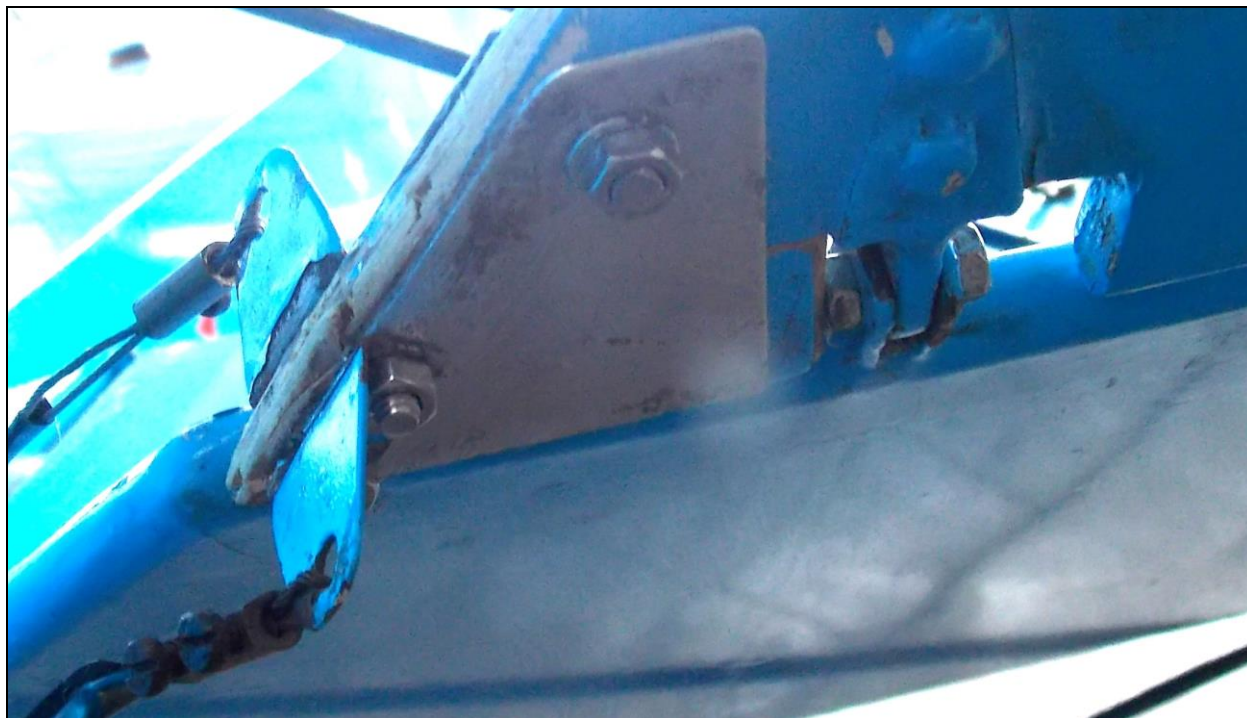
Ilustracja nr 2 [zdjęcie PKBWL]. Widok na uszkodzone miejsce po doraźnej naprawie.
