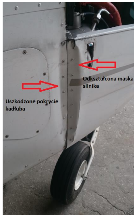
Rys. 5 Odształcenie poszycia wskazująca na uszkodzenie łoża silnika [źródło: użytkownik / PKBWL]
