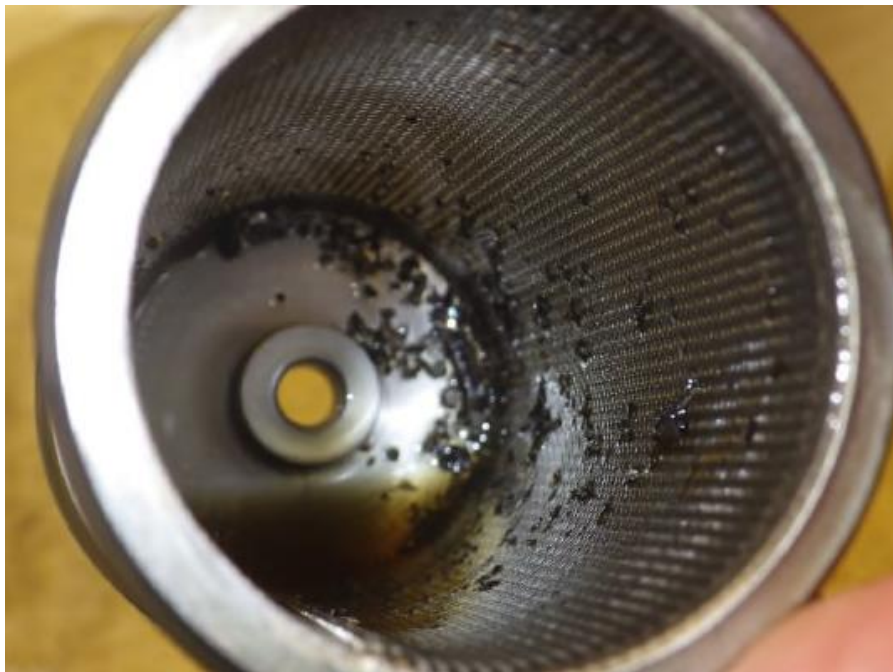
Rys. 17 Opiłki w filtrze głównym instalacji olejowej [źródło: P&WC]
