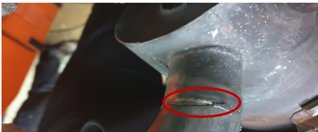
Rys.1 Widok pękniętej rury wylotowej [źródło, użytkownik]
