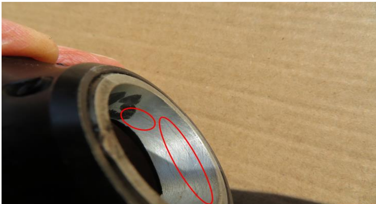
Rys. 7. Pęknięcia na wewnętrznej powierzchni urwanej końcówki łopaty [źródło: PKBWL]
