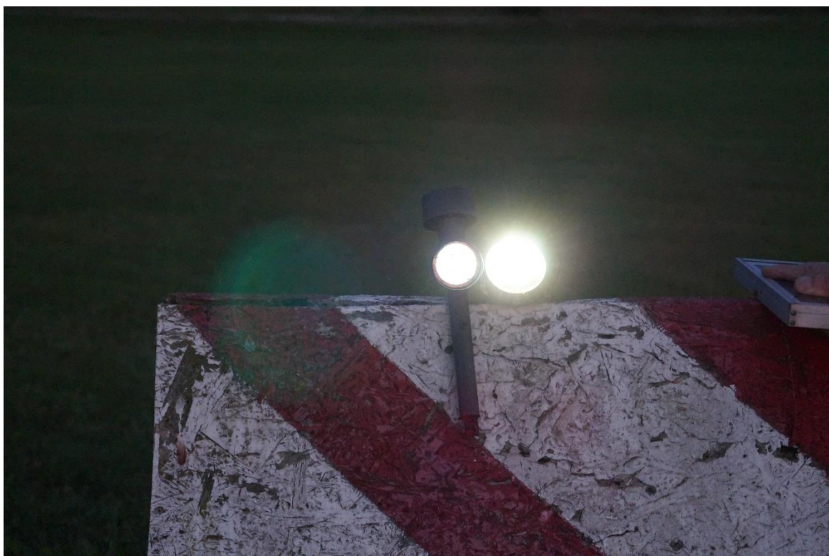
Rys. 7 Lampki solarne na progu pasa startowego (źródło PKBWL)
