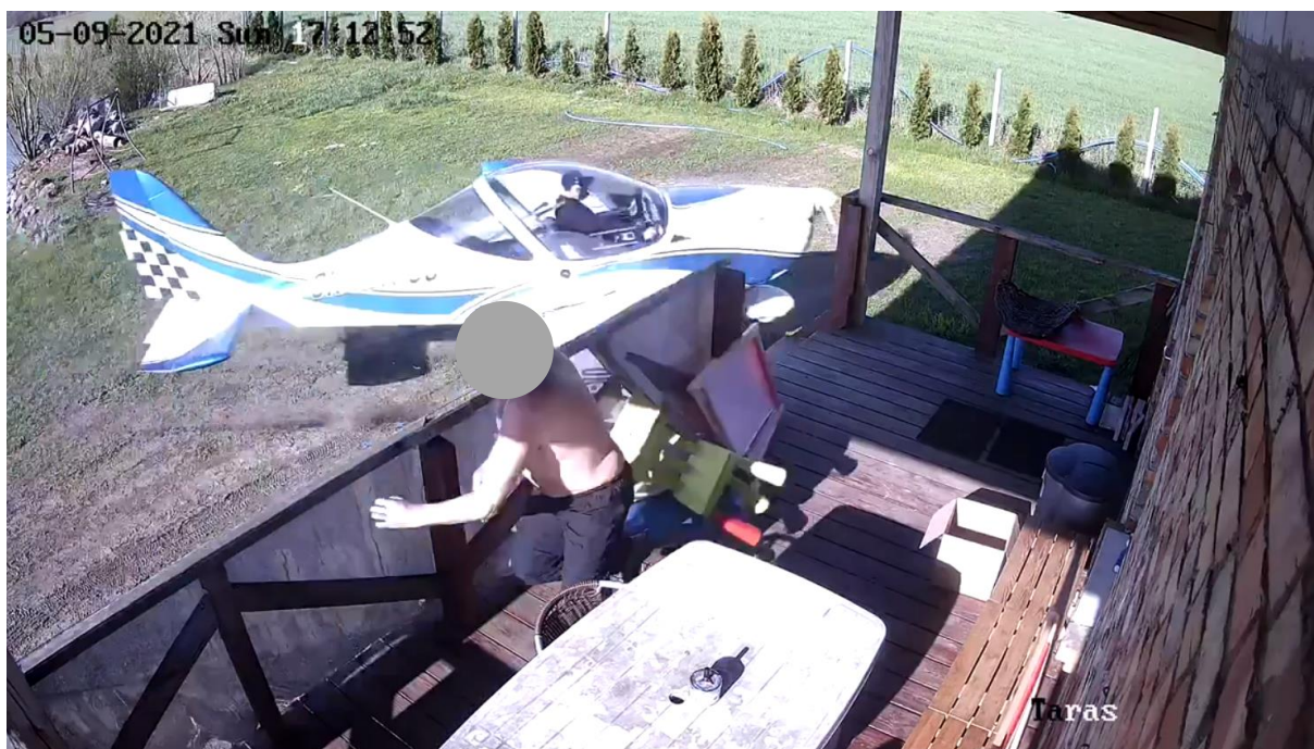
Rys. 10 Podczas uderzenia samolotu w budynek, na tarasie znajdował się człowiek. Zapis video ukazuje znikomą odległość pomiędzy skrzydłem a tą osobą [źródło: PKBWL]
