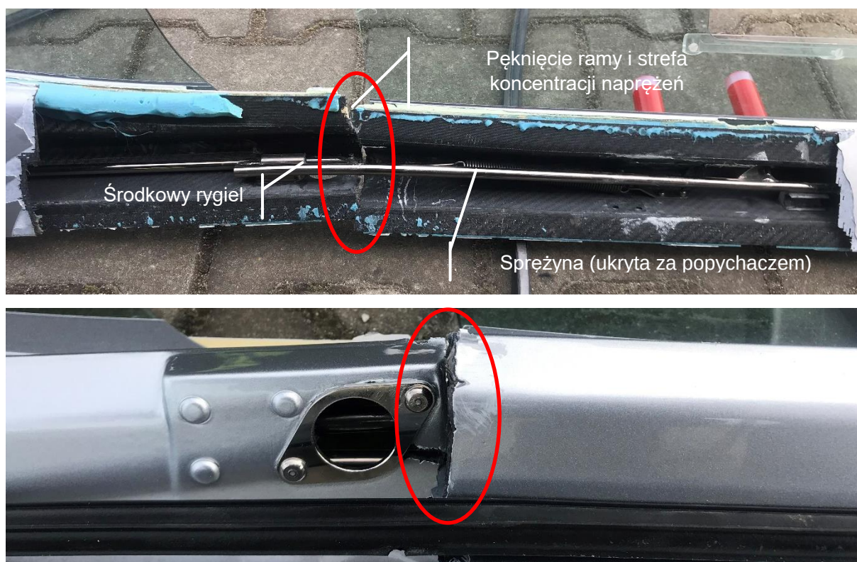
Rys. 8 Pęknięta „na wskroś” rama osłony kabiny w pobliżu miejsca osadzenia środkowego rygla. Karb występuje na krawędzi wzmocnienia otworu pod okucie/zamek na ramie. [źródło: PKBWL]
