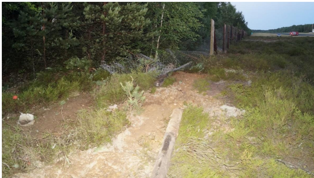
Rysunek 6. Zerwana siatka ogrodzeniowa oraz wyrwany słup drewniany.
