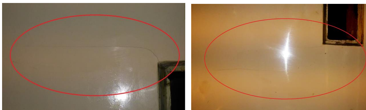
Ilustracja nr 2. Pęknięcia poszycia dolnej powierzchni skrzydeł przy skrynkach hamulcowych.
