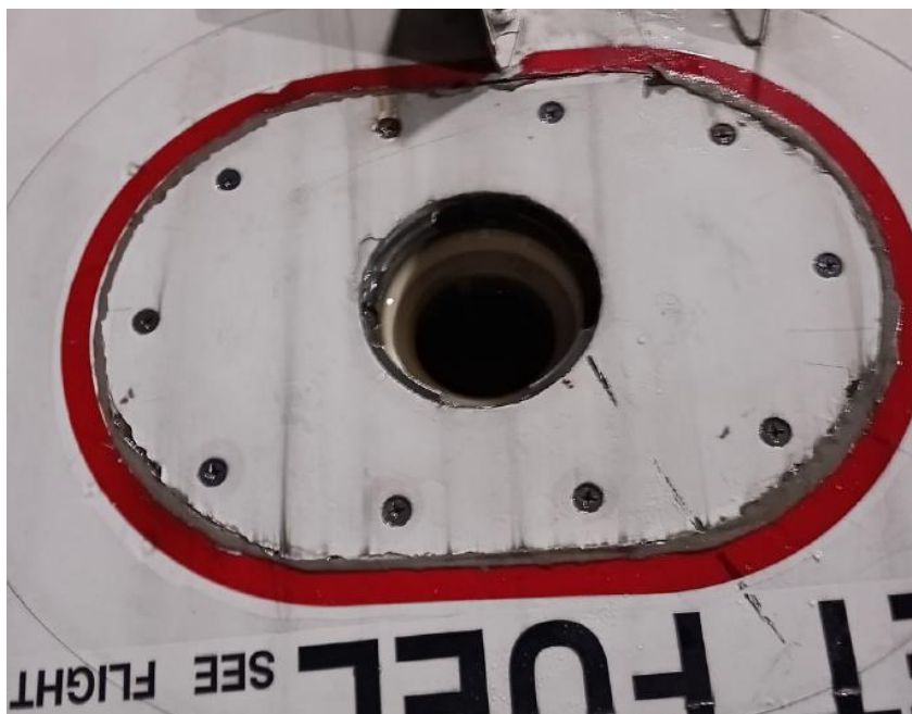
Rys.1. Ujawniony po lądowaniu brak korka grawitacyjnego na górnej powierzchni skrzydła samolotu ATR-72 o znakach SP-SPN. [źródło: Podmiot badający incydent].
