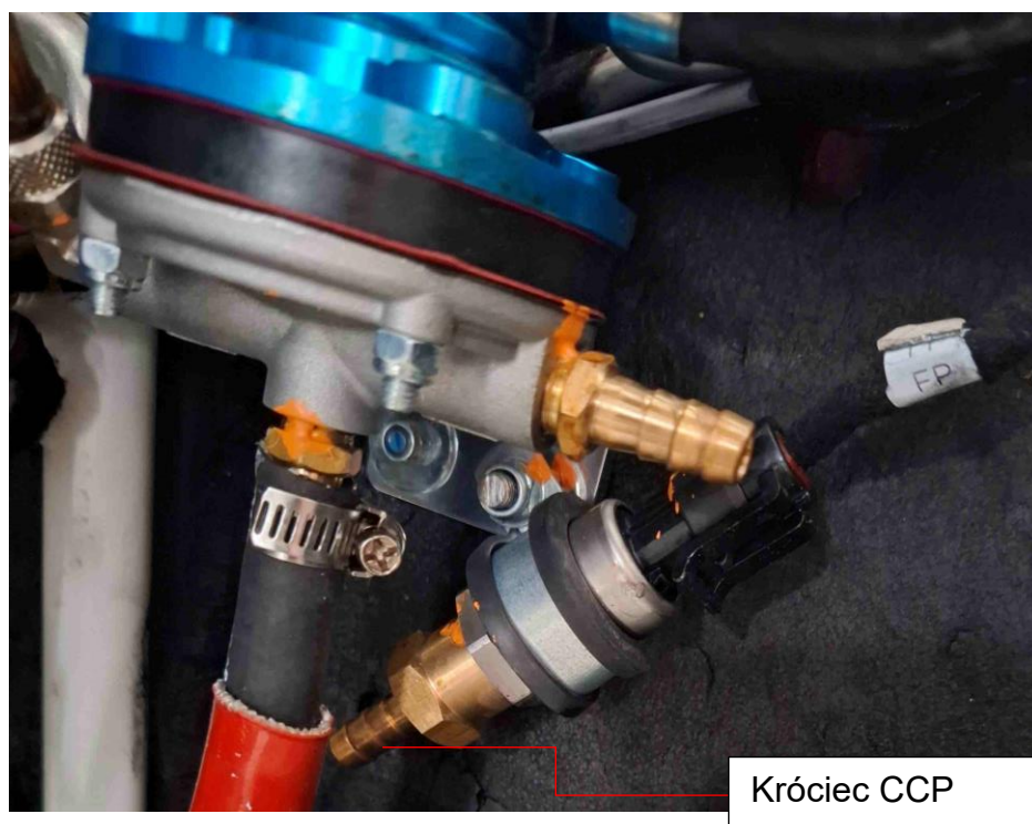
Rys. 4. Prawdopodobne miejsce przecięcia przewodu paliwowego na króćcu CCP. [źródło: PKBWL]
