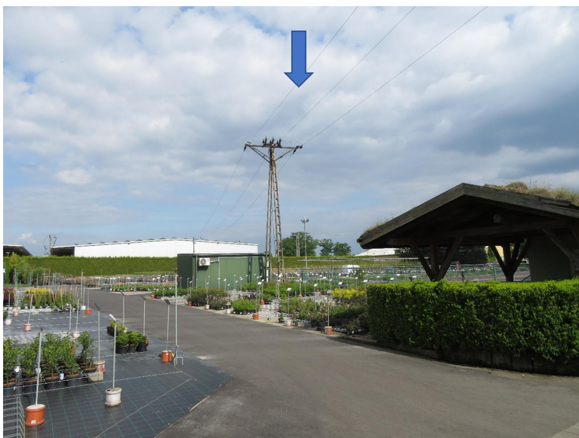
Rys. 2. Miejsce uderzenia BSP w linię energetyczną (przybliżone)
